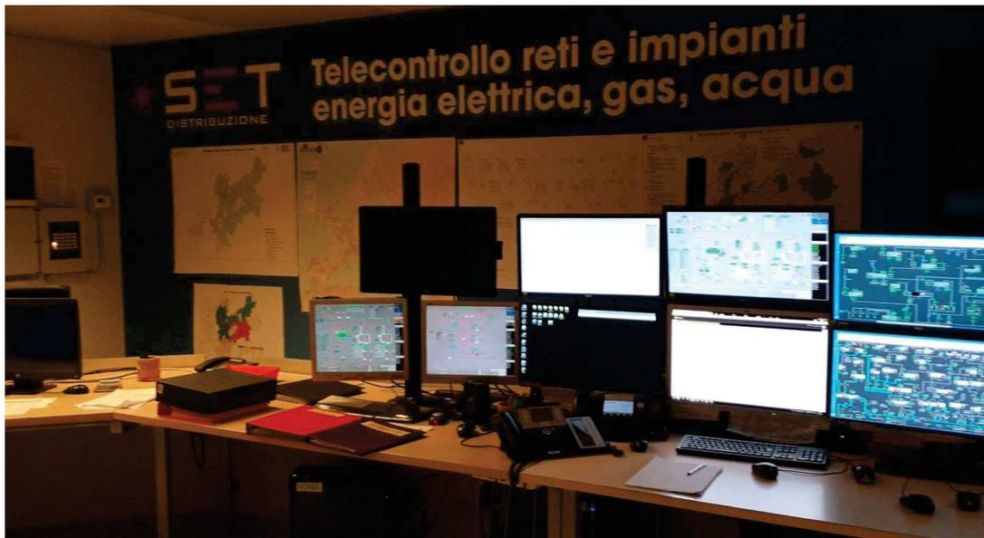
Figura 6: dettagli dei sistemi di misura di portata e cloro residuo (alto a sinistra e centro), periferiche telecontrollo (alto destra) e centrale telecontrollo (in basso) del sistema
