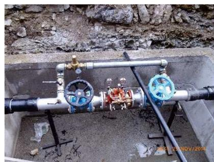
Figura 4: Dettagli valvola riduttrice di pressione in viale dei Colli.
