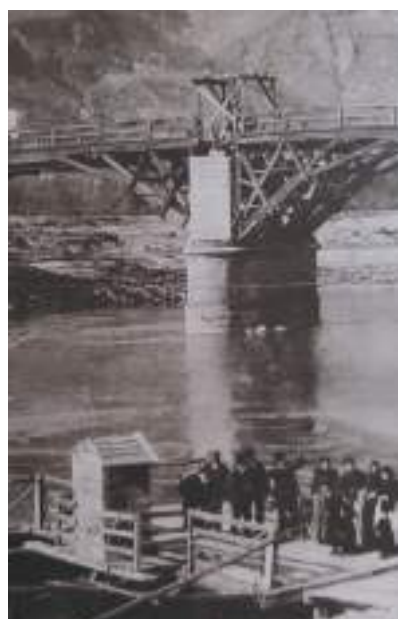
Ultimi viaggi della zattera con il ponte in costruzione (Borgo Sacco)
