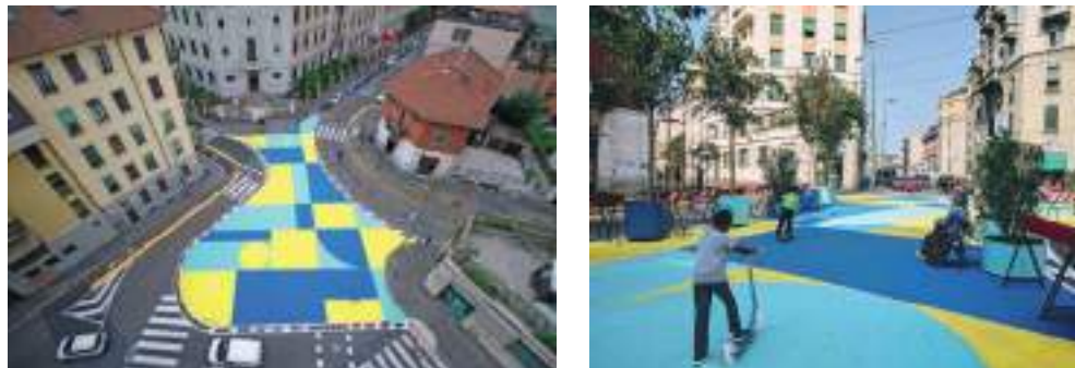
PIAZZE APERTE MILANO Ripavimentazione temporanea con l'utilizzo del colore sull'asfalto per testare nuove aree pedonali.
