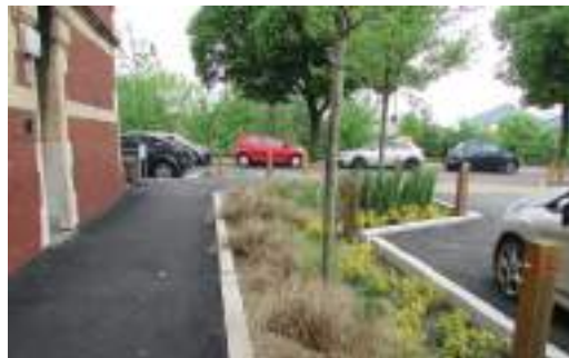
RETROFITTING IN GALLES Utilizzo delle aiuole esistenti per diminuire il runoff superficiale delle acque meteoriche. Qualità estetica di aree verdi inutilizzate
