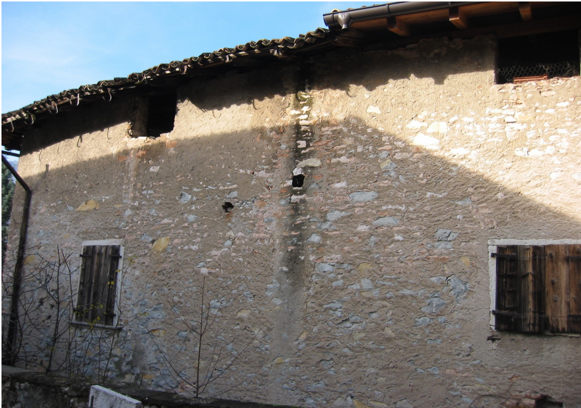
p.ed. 704/1 : dettaglio vista lato EST
