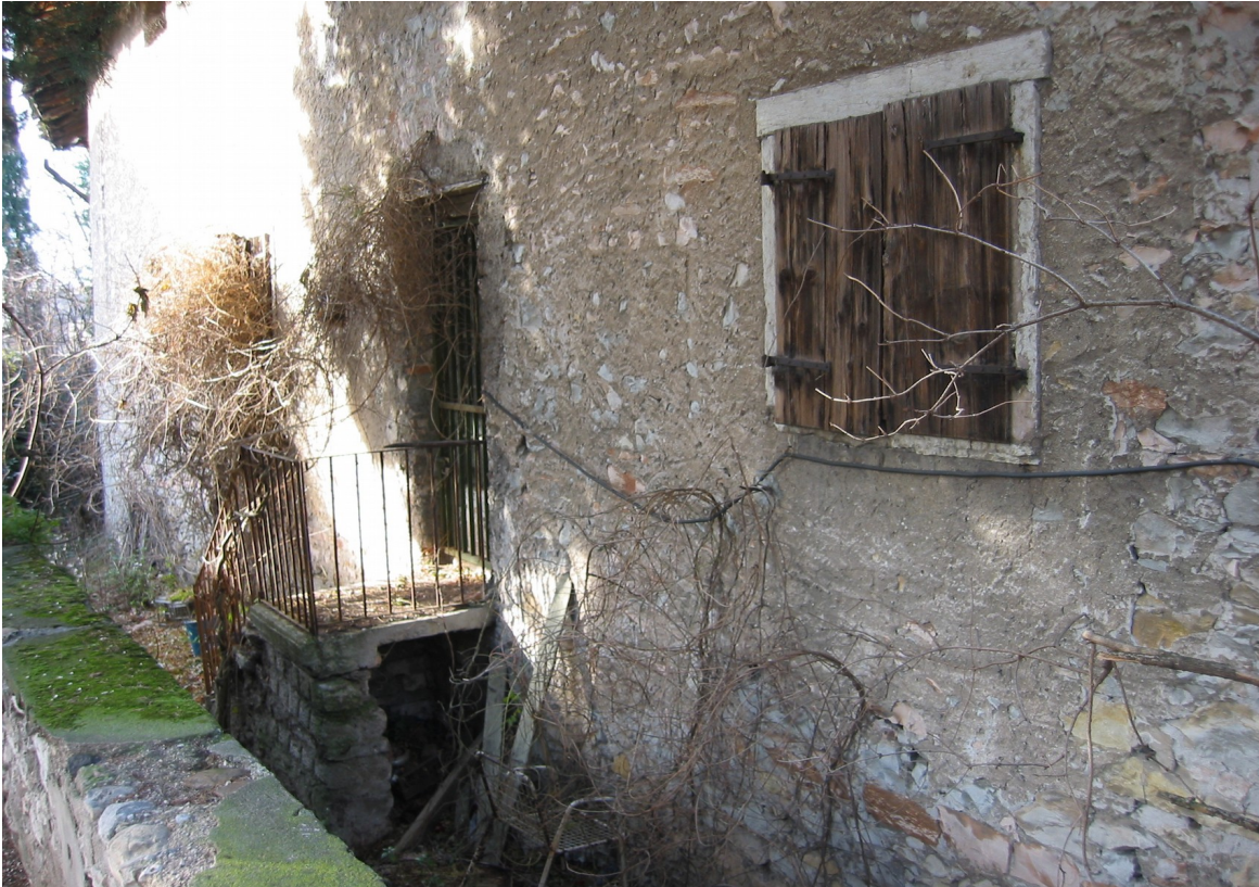
p.ed. 704/1 : dettaglio vista lato EST
