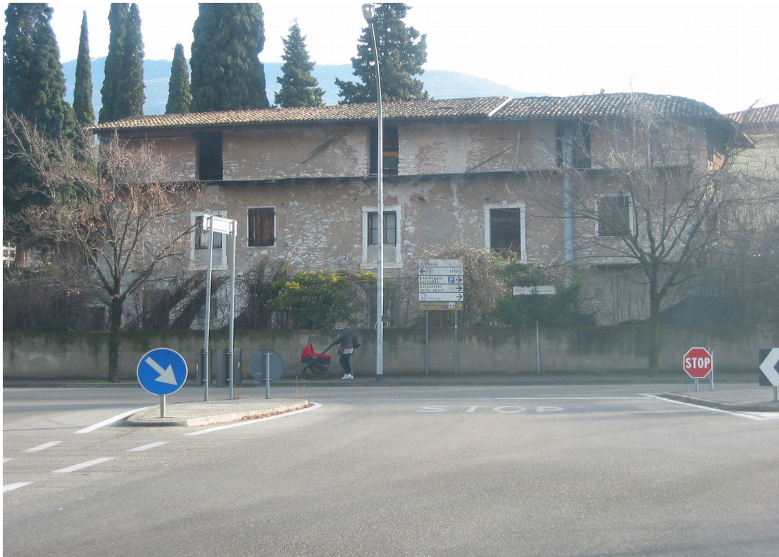
p.ed. 704/1 : VISTA DA OVEST
