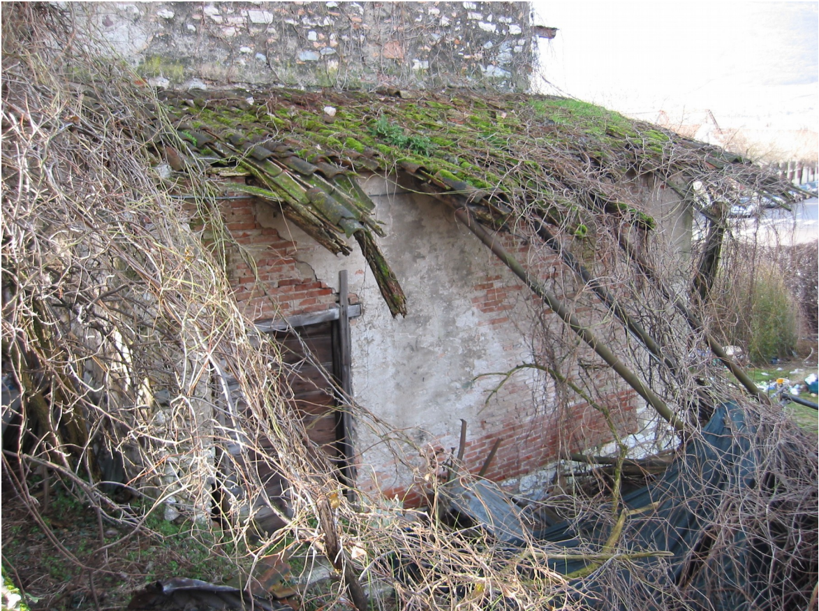
p.ed. 704/1 : dettaglio vista lato NORD
