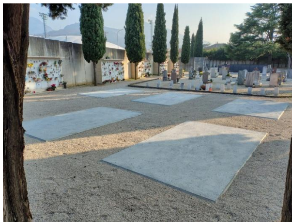
Platee loculi ossari posati in feb 2026 nella zona di via Sabbioni dove andranno installate i primi 280 loculi ossari
