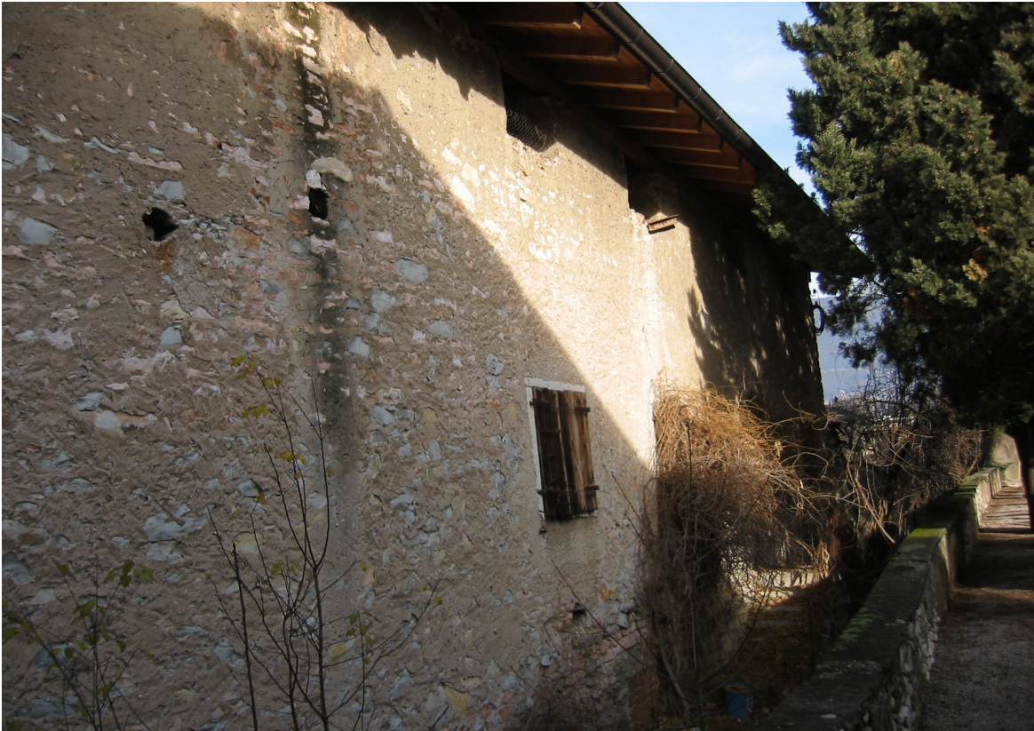
p.ed. 704/1 : dettaglio vista lato EST
