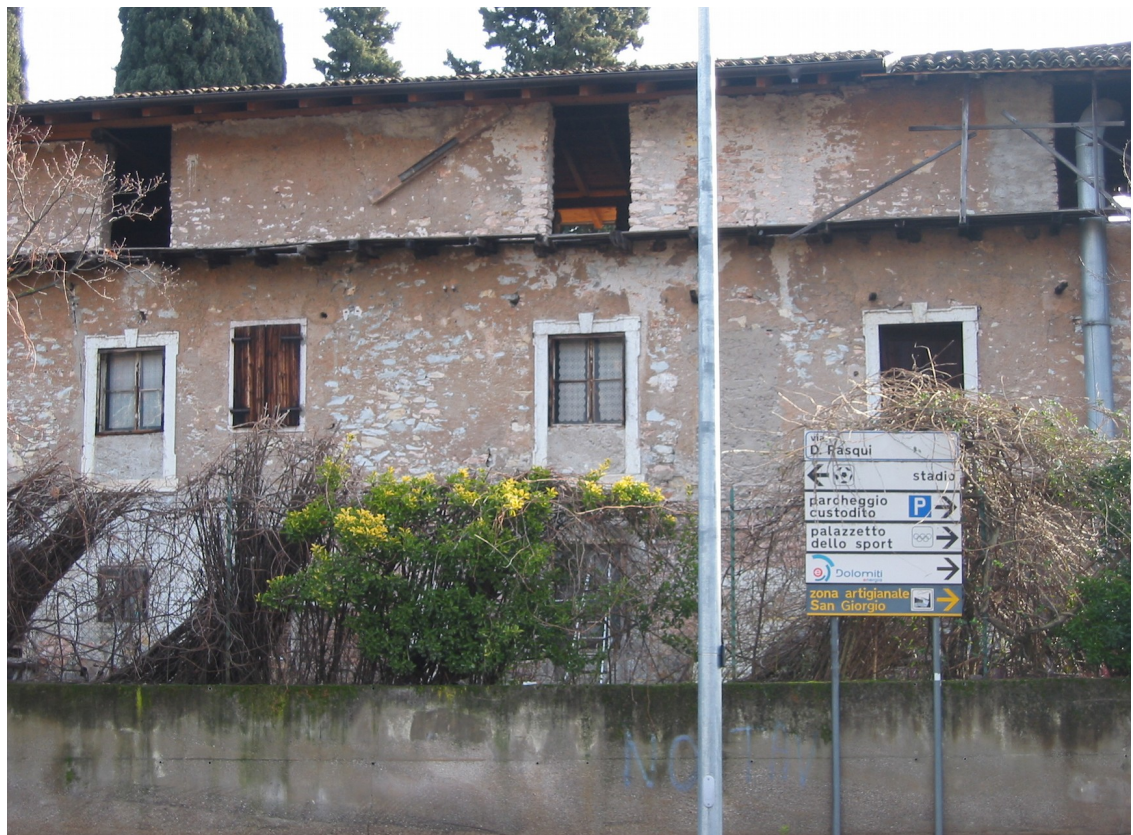
p.ed. 704/1 : dettaglio vista lato OVEST
