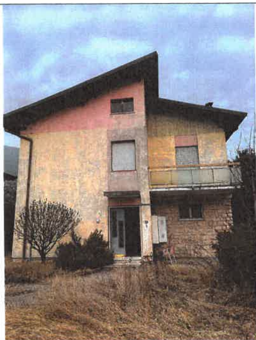
Prospetto a sud
