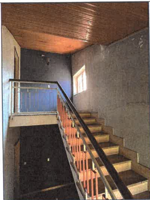
Vano scale che porta al sottotetto
