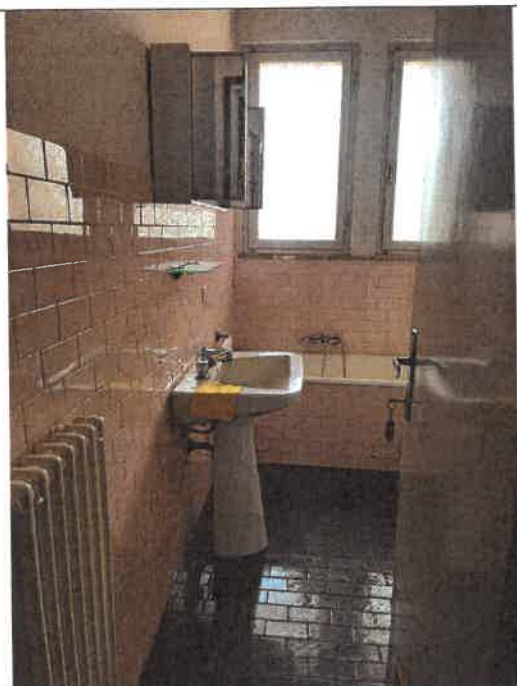
WC piano primo
