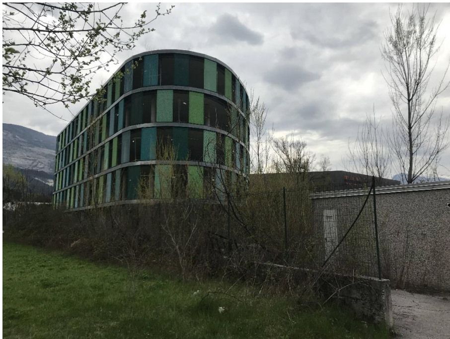
Foto 6: Vista generale manufatti esistenti all'interno dell'area di intervento
