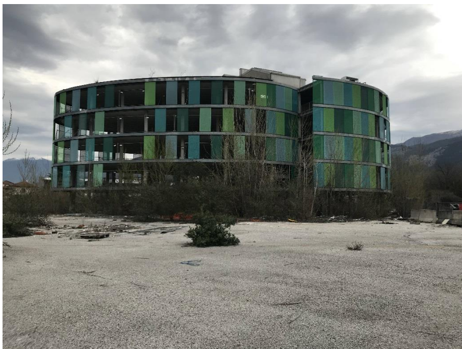
Foto 7: Vista manufatto esistente a sud
