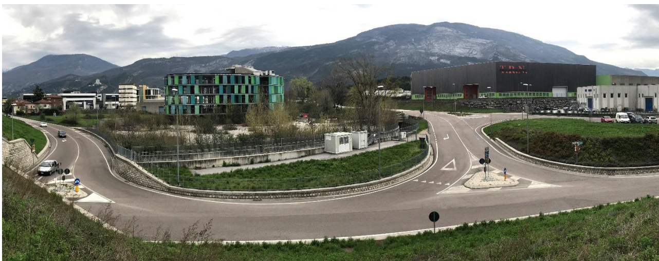
Foto 2: Vista panoramica area di intervento e viabilità a servizio dell'area
