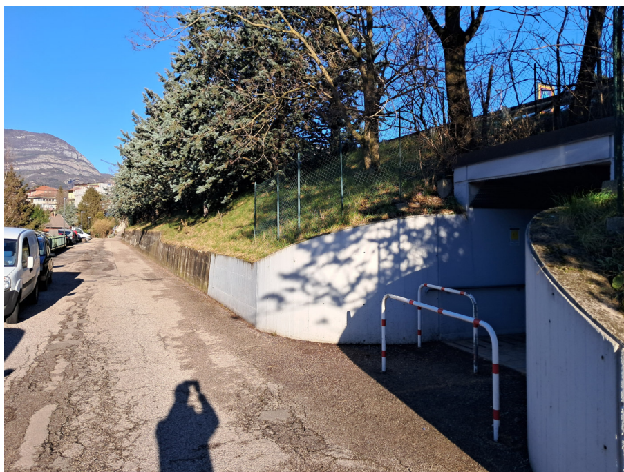
Via Stivo con ingresso sottopasso pedonale
