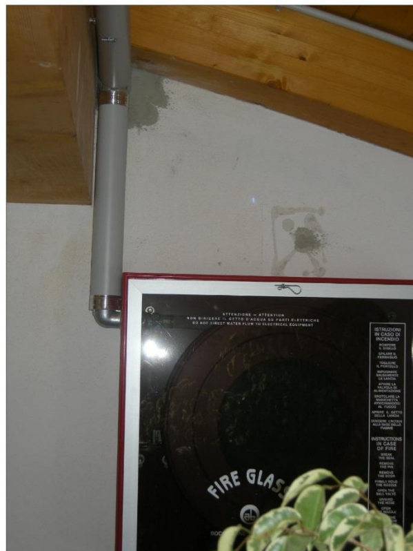
FOTO ANTINCENDIO 4: NASPO UNI 25 PIANO PRIMO
