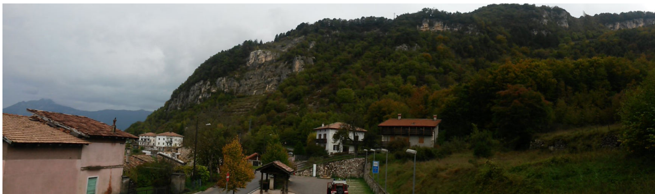
Località Cisterna-Moietto. Sono visibili le pareti rocciose da dove possono verificarsi dei crolli
