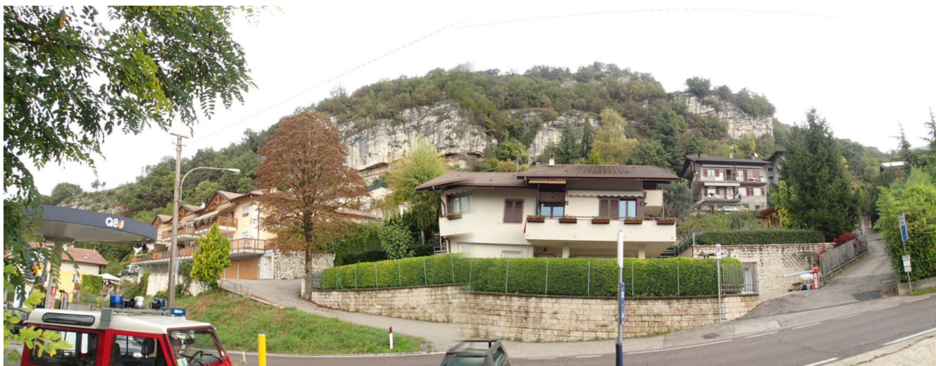
La parete rocciosa a monte di località Campolongo sorgente dei crolli che minacciano le abitazioni sottostanti
