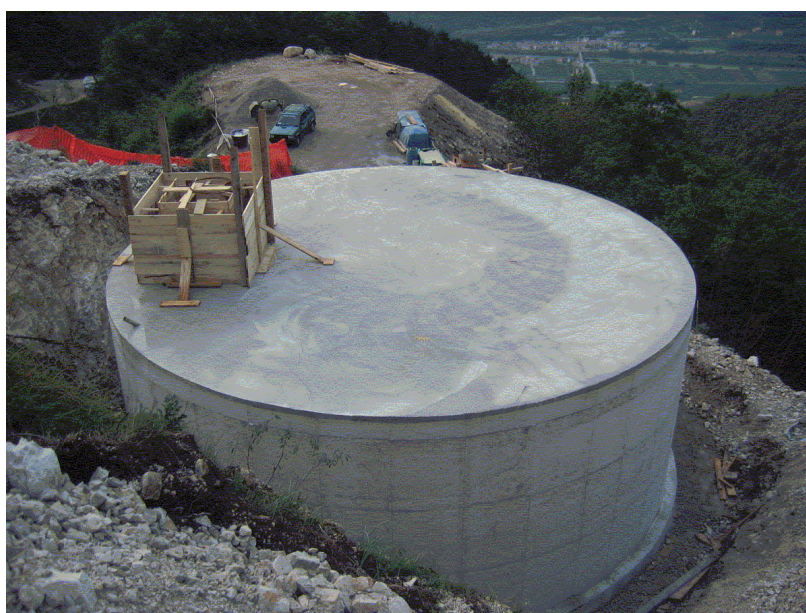
Figura 8.6 - Serbatoio interrato in calcestruzzo in fase di costruzione
