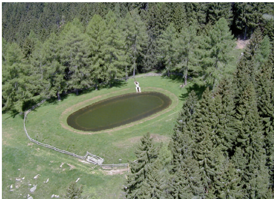
Figura 8.7 - Bacino di accumulo a cielo aperto
