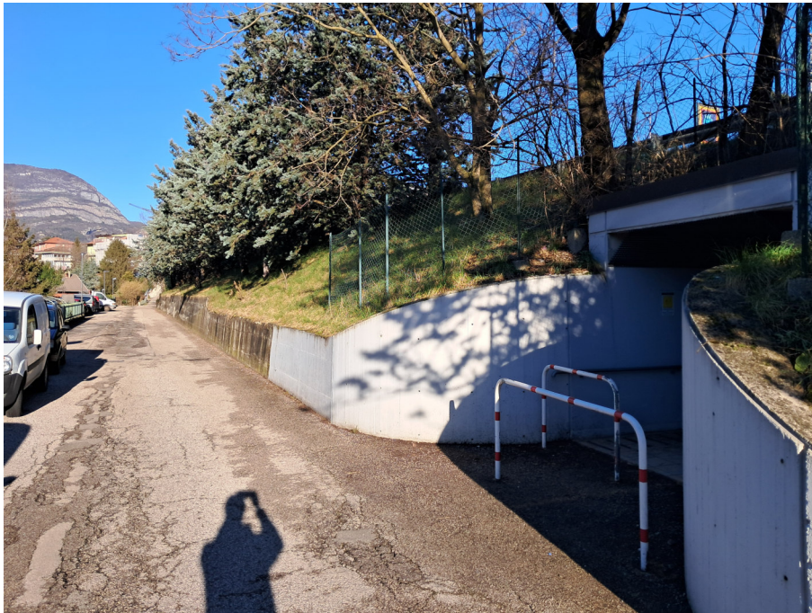
Via Stivo con ingresso sottopasso pedonale
