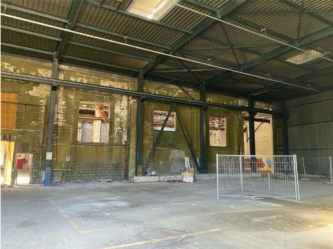
Foto 19 - L'intero del capannone in acciaio da demolire
