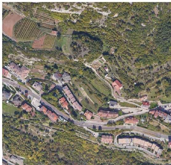
Situazione attuale (google maps) – scala a vista
