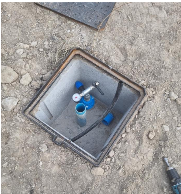
Figura 4.1: Pozzo di sparging.
