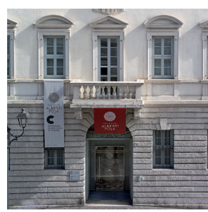
Palazzo Alberti Poja, la sala affrescata e l'ingresso
